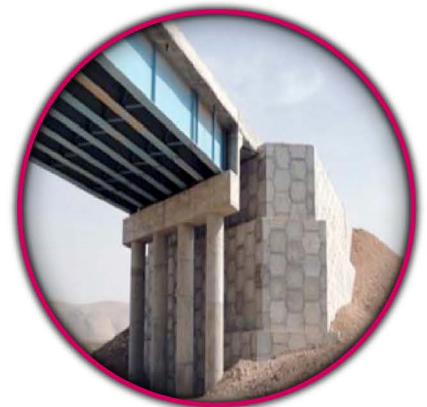
شیب‌راه و دیواره‌ی پشت کوله پل:
